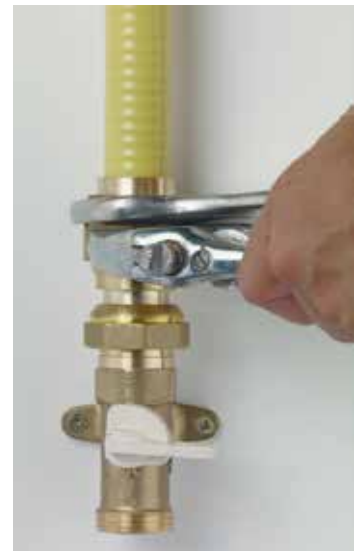
Beëindig de aansluiting zonder onnodige inspanning
